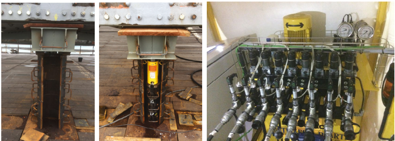
Figura 14 – Calços metálicos, Macacos e unidade hidráulica utilizados na transferência de cargas.
