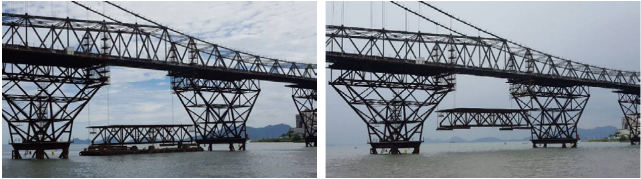
Figura 12 – Montagem das treliças intermediárias da estrutura auxiliar.
