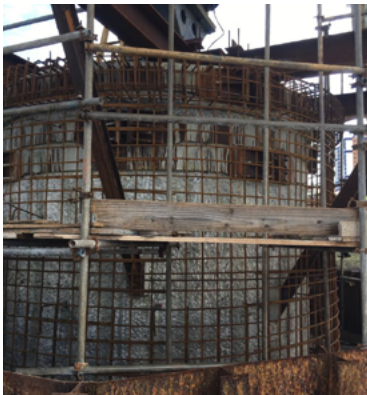
Figura 15 – Instalação das ensecadeiras e procedimento de reforço das fundações .
