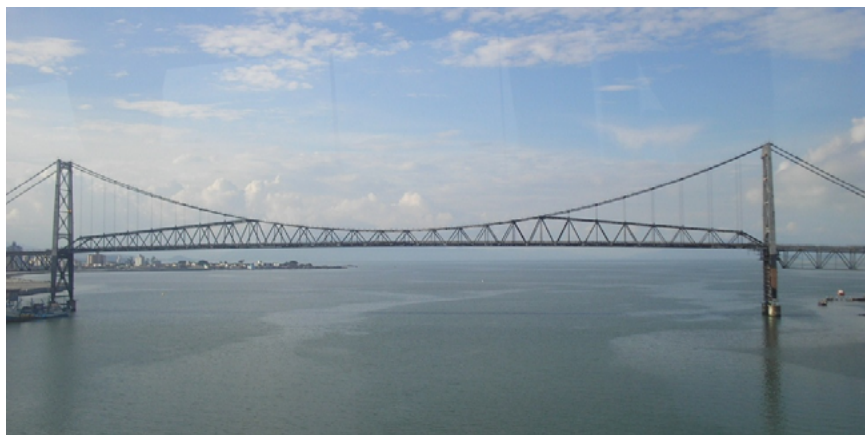
Figura 1 – Vão central pênsil da Ponte Hercílio Luz, com 339,5 m de comprimento.
