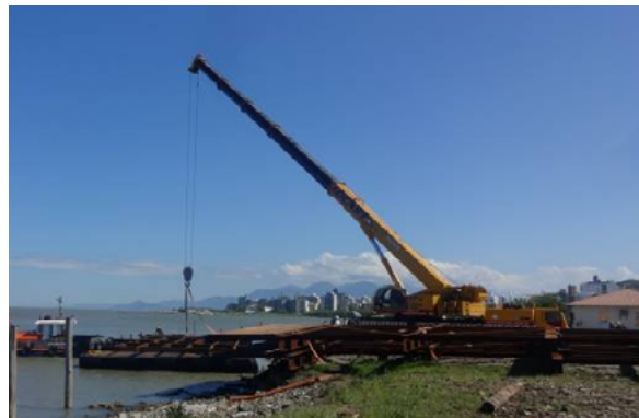
Figura 10 – (a) Pré-montagem da treliça da estrutura auxiliar no canteiro (b) Transporte das treliças em flutuantes.
