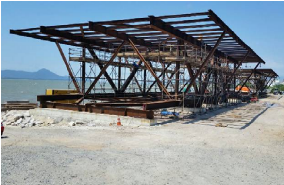
Figura 10 – (a) Pré-montagem da treliça da estrutura auxiliar no canteiro (b) Transporte das treliças em flutuantes.
