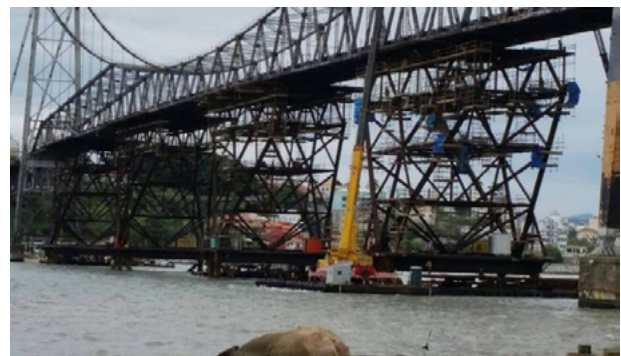
Figura 11 – Montagem das torres da estrutura auxiliar.
