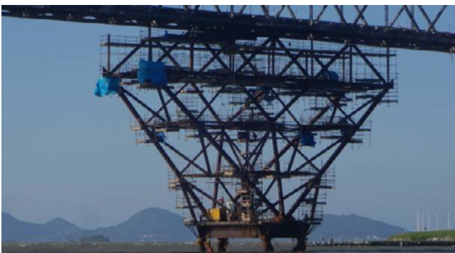
Figura 11 – Montagem das torres da estrutura auxiliar.
