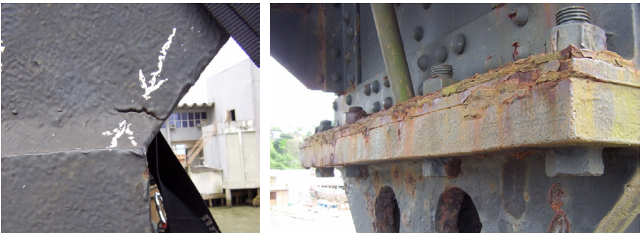
Figura 2 – Fissuras e elevado estágio de corrosão das bases dos pilões.
