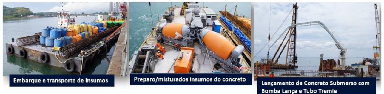
Figura 9 – Ciclo de concretagem das estacas (TRBA, 2013).
