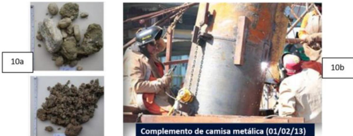
Figura 10 – (a) Presença de seixos. (b) Solução adotada (TRBA, 2013).
