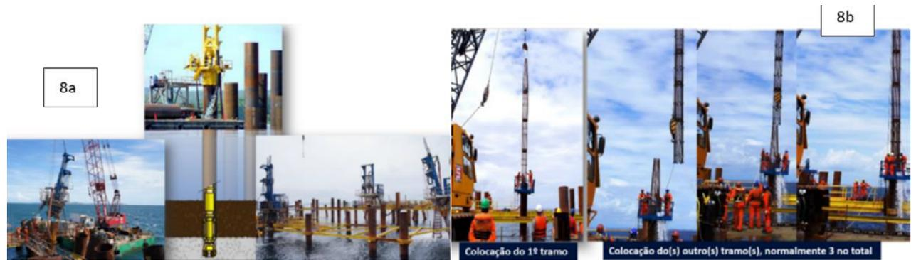
Figura 8 – (a) Escavação em solo /perfuração em rocha e (b) Armação (TRBA, 2013).
