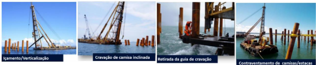
Figura 7 – Içamento, cravação, retirada da guia e contraventamento de camisas metálicas. (TRBA, 2013)
