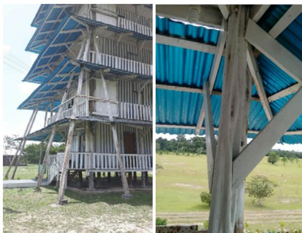
**Figura 2 – Pilares inclinados e principais.**
