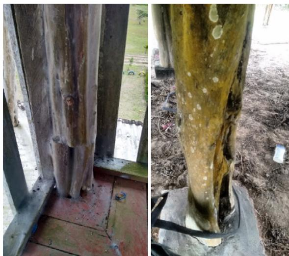
**Figura 17** – Acúmulo de sujeira e mofo peças estruturais.
