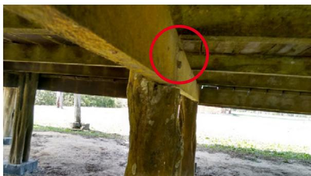
**Figura 4 – Ligação viga-pilar.**
