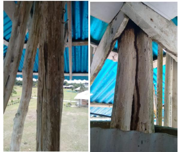
**Figura 13** – Pilar P1 e Pilar P5.
