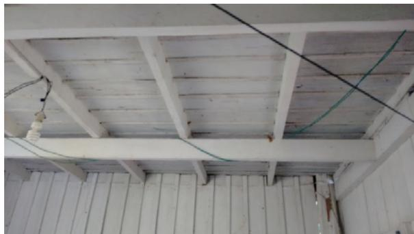
**Figura 3 – Vigas principais e assoalho de madeira.**
